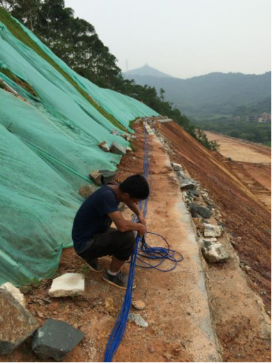
Inclinometer wiring
